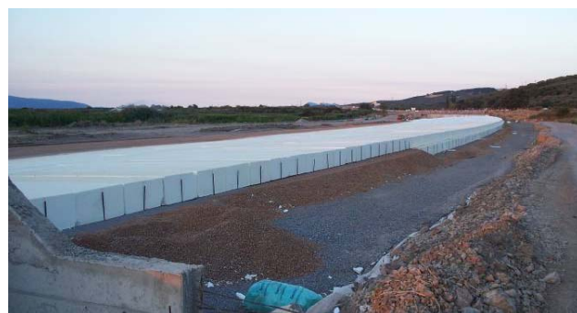
Σχήμα 9: Άποψη του επιχώματος EPS Figure 9: View of EPS construction
